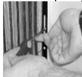
Completar la instalación encajando el imán (4) en el perfil imán (5a).
